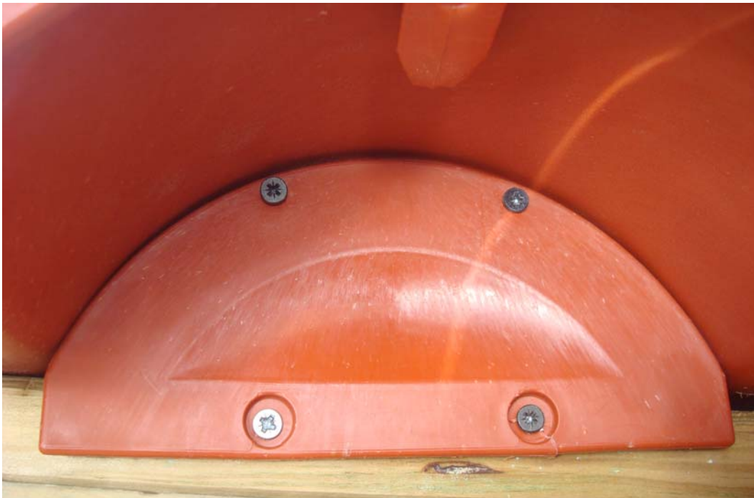
Foto de cierre antipájaros instalado
