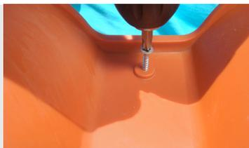
2. A instalação inicia-se da esquerda para a direita e de baixo para cima. Aparafusam-se à ripa nas anilhas marcadas no canal do painel.
