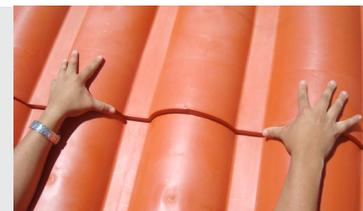
3. Na linha seguinte, o painel desliza empurrando-o de baixo para cima, juntando até ao fundo o macho e a fêmea da fixação.
